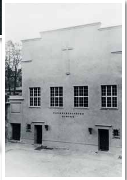
1940 Kirche Packhofstraße Stadtgemeinde
