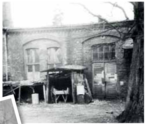
1909 Privatschule Spitta Turnhalle
