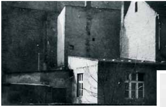
1937 Raum auf dem Hinterhof einer Gaststätte in der Wollenweberstraße
