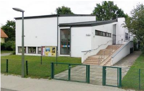
Gemeindezentrum am Geflügelsteig 22/28
